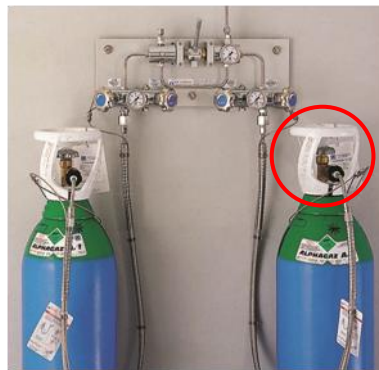
รูปที่ 2.2 ตัวอย่างถังแก๊สที่มี guard ป้องกันหัวถัง ขณะใช้งาน (ที่มา เข้าถึงได้จาก http://proactivegassafety.com/gas-safety-training-workshops/laboratory-gas-users-workshop สืบค้นเมื่อวันที่ 27 กรกฎาคม 2556)
