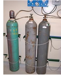
รูปที่ 2.1 ตัวอย่างการวางถังแก๊สที่เหมาะสมในห้องปฏิบัติการ (ที่มา เข้าถึงได้จาก http://blink.ucsd.edu/safety/research-lab/chemical/gas/storage.html#Basic-storage-guidelines-for-al สืบค้นเมื่อวันที่ 2 สิงหาคม 2556)
