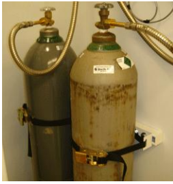
รูปที่ 2.1 ตัวอย่างการวางถังแก๊สที่เหมาะสมในห้องปฏิบัติการ (ที่มา เข้าถึงได้จาก http://blink.ucsd.edu/safety/research-lab/chemical/gas/storage.html#Basic-storage-guidelines-for-al สืบค้นเมื่อวันที่ 2 สิงหาคม 2556)
